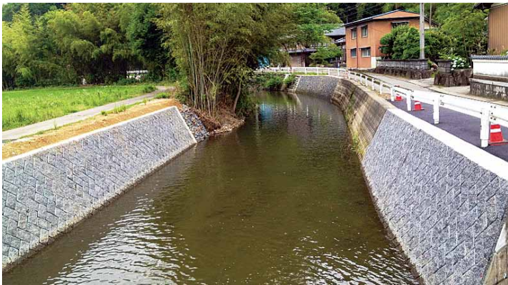
護岸の復旧工事は完了した
