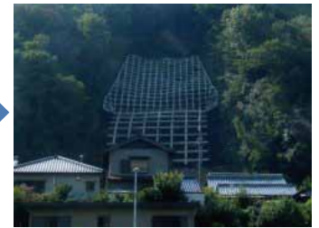
対策完了状況
